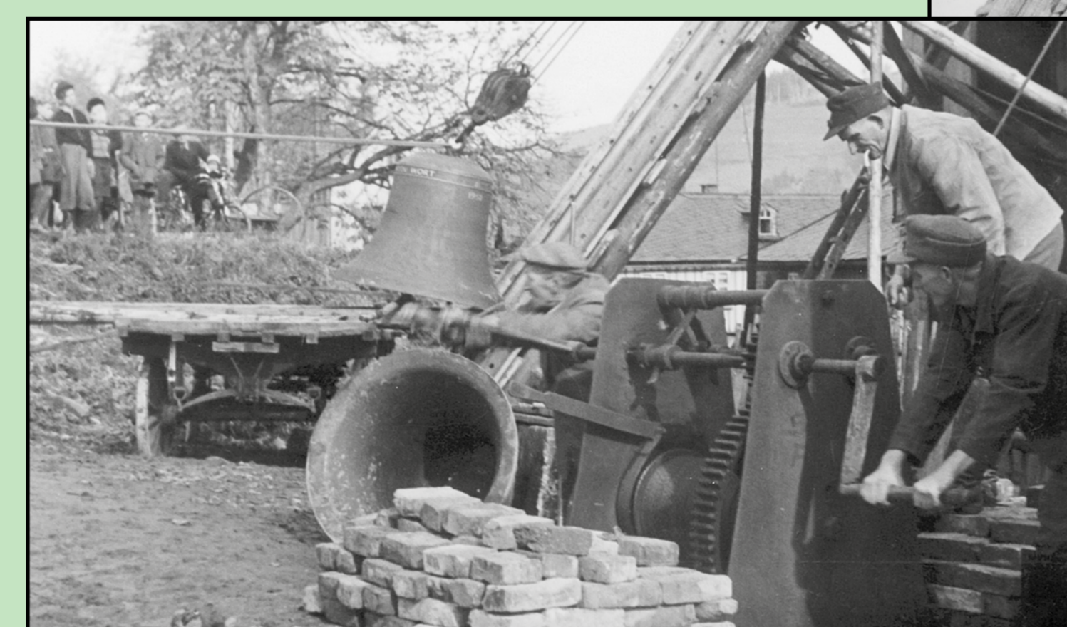
Mit Muskelkraft gelangen die 3 Glocken über eine schiefe Ebene in den Glockenturm.
